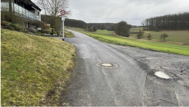
Anbindung der öffentlichen Verkehrsfläche an Orts-Straße „Krumbachweg“
