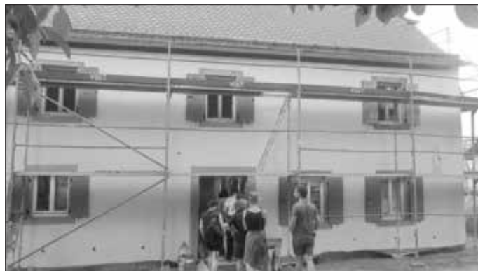
Die Sanierung des unter Denkmalschutz stehenden Forsthauses in Werneck ging Hand in Hand mit dem Landesamt für Denkmalpflege. Foto: Interkommunale Allianz Oberes Werntal
