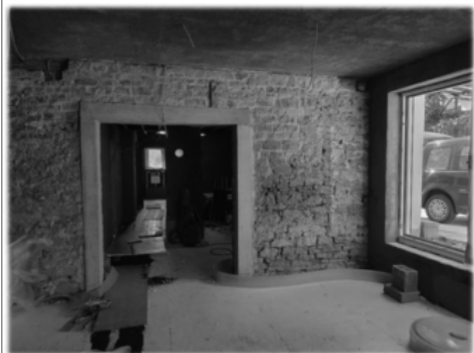
Eine einzigartige Wohnatmosphäre entsteht durch die Kombination von altem Mauerwerk und Moderne.
