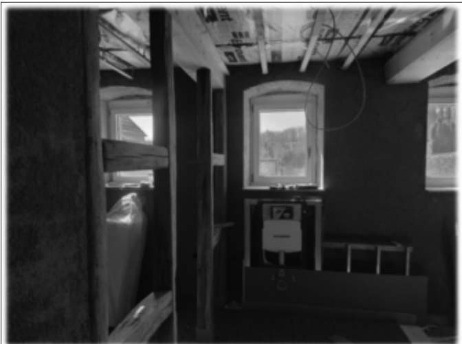
Hier werden Fachwerkbalken auf Sicht gelassen und als Raumteiler genutzt.
