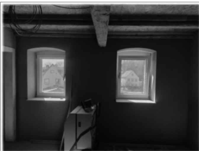
Bestehende Fensterbänke werden durch neue ergänzt.
