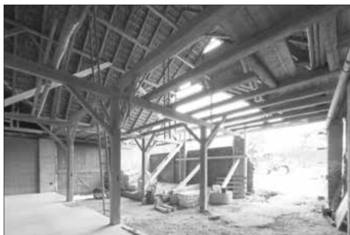
Bildtitel: Sanierung der Energiescheune in Niederwerrn
