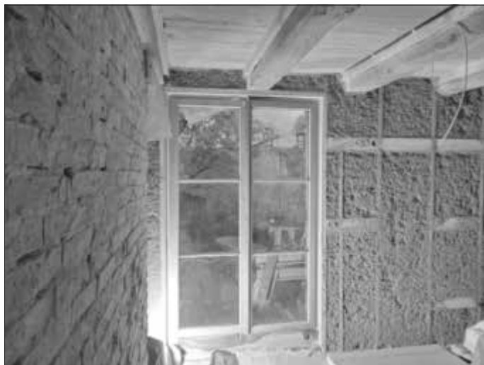
Verarbeitung von Hanfbeton
