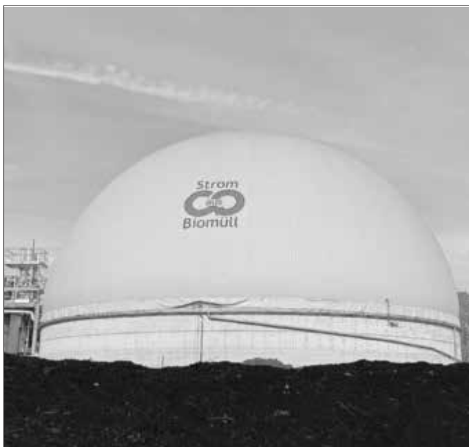
Die Kuppel der Biogasanlage am Abfallwirtschaftszentrum Rothmühle
