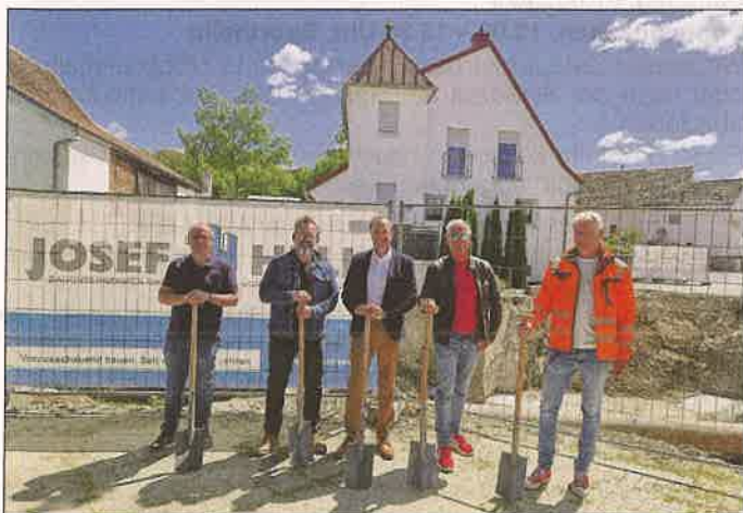
Auf dem Bild (von links): Dirk Schlereth, Bauleiter Fa. Hell; Matthias Kirchner, Inhaber Büro Bautechnik Kirchner; 1. Bürgermeister Ludwig Nätscher, Gemeinde Poppenhausen; Thomas Hahn, Geschäftsleiter Gemeinde Poppenhausen; Peter Straub, Oberbauleiter Fa. Hell Foto: Katharina Wirsching
