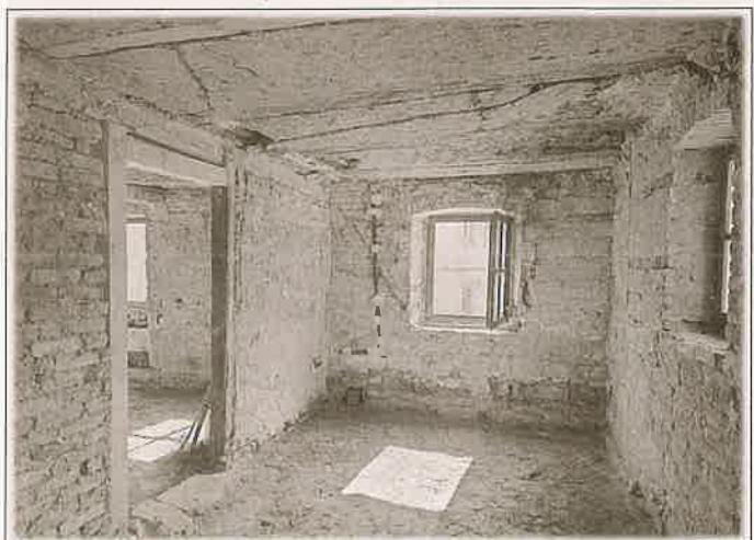
Das Bild zeigt den Umbau zur barrierearmen Wohnung durch Vergrößerung der Türrahmen.
